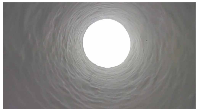
Cev posle sanacije
